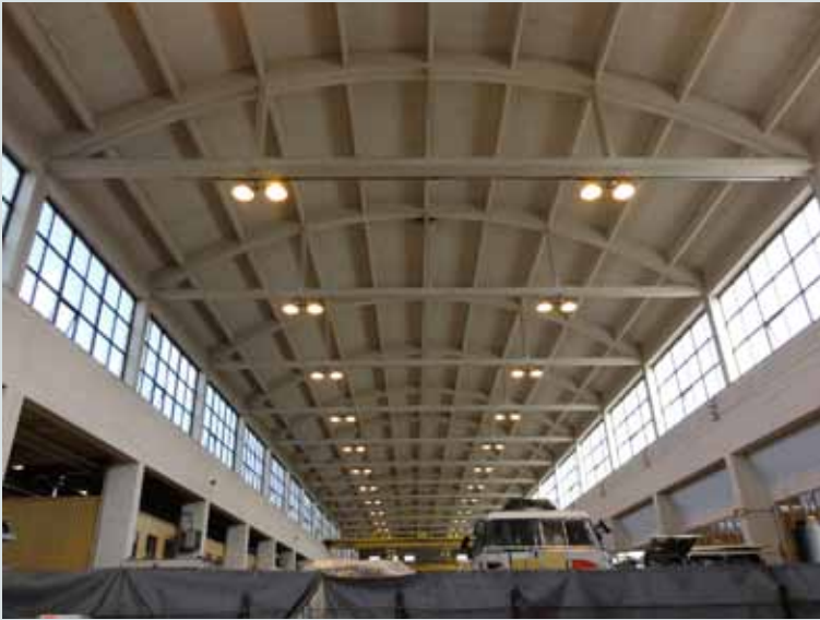
VR:n konepajan komeaa betoniholvausta 1949, VR:n huonera-kennusosasto.
